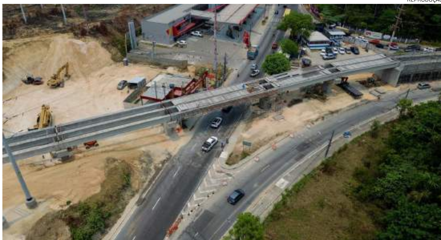
Viaduto fica localizado entre as avenidas Rio Preto e Governador José Lindoso
