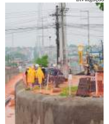
Obras acontecem no Jorge Teixeira
