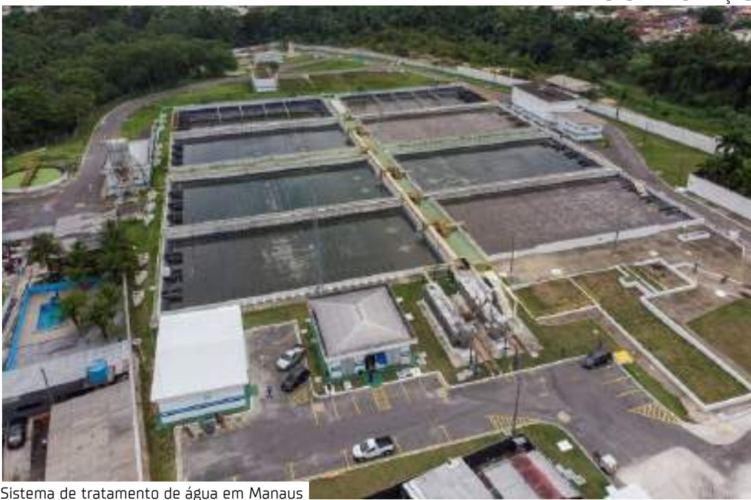
Sistema de tratamento de água em Manaus
