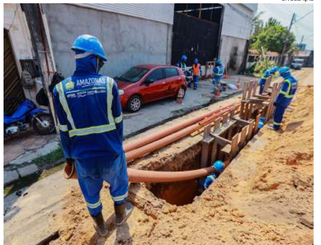
Atividades estão em andamento no bairro Armando Mendes
