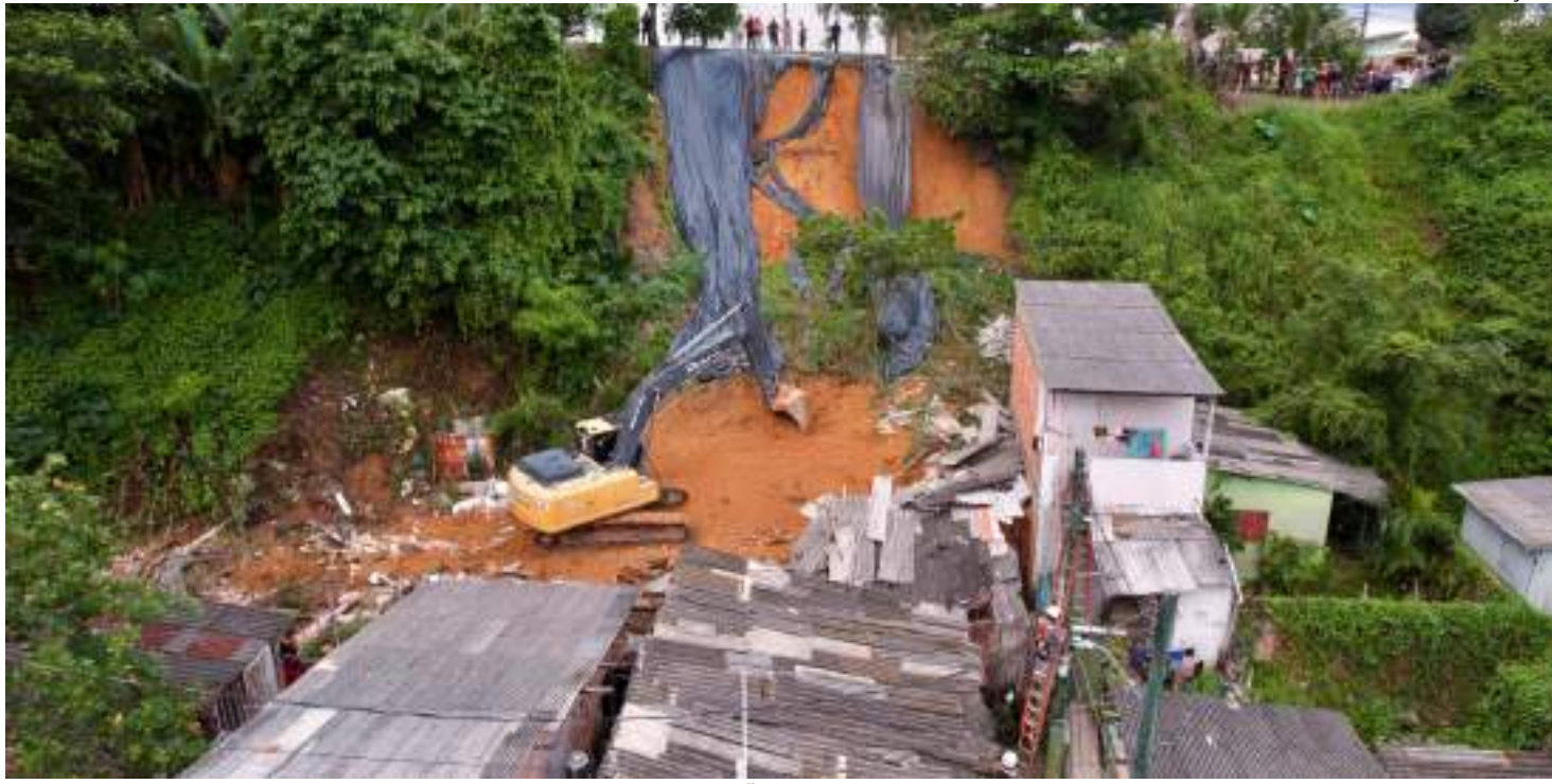
Dois pessoas morreram durante desabamento no bairro Redenção, Zona Centro-Oeste
