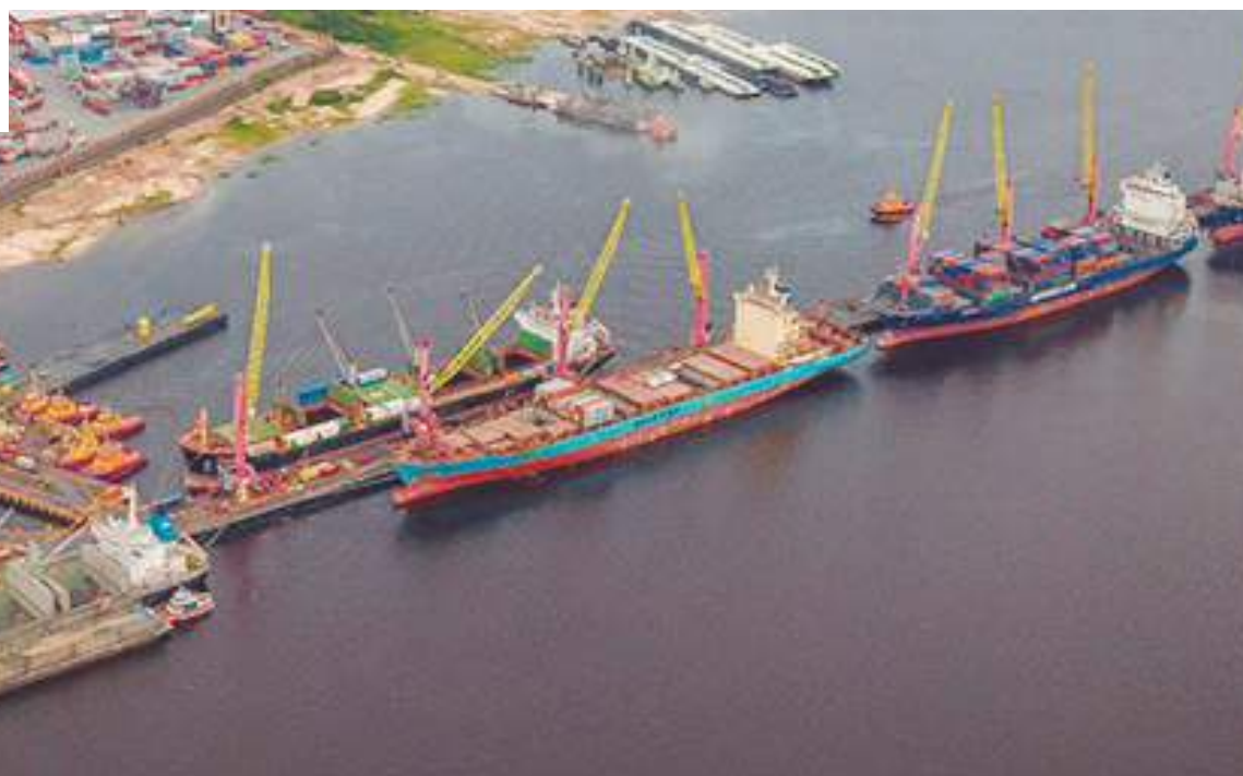
Chibatão é responsável pela construção de pier flutuante para transporte de cargas
