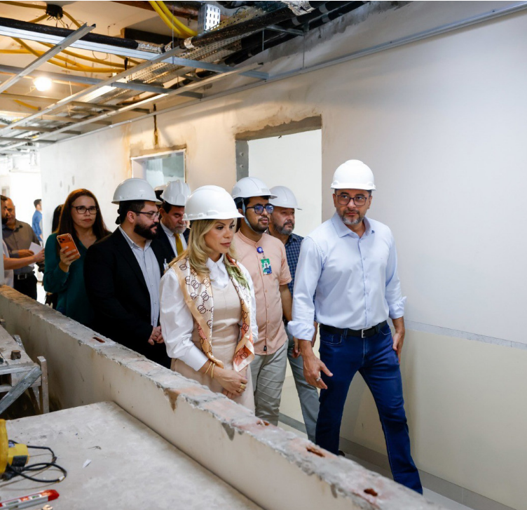
Hospital-Dia e Policlínica do Complexo Hospitalar Sul chegam a 90% das obras
