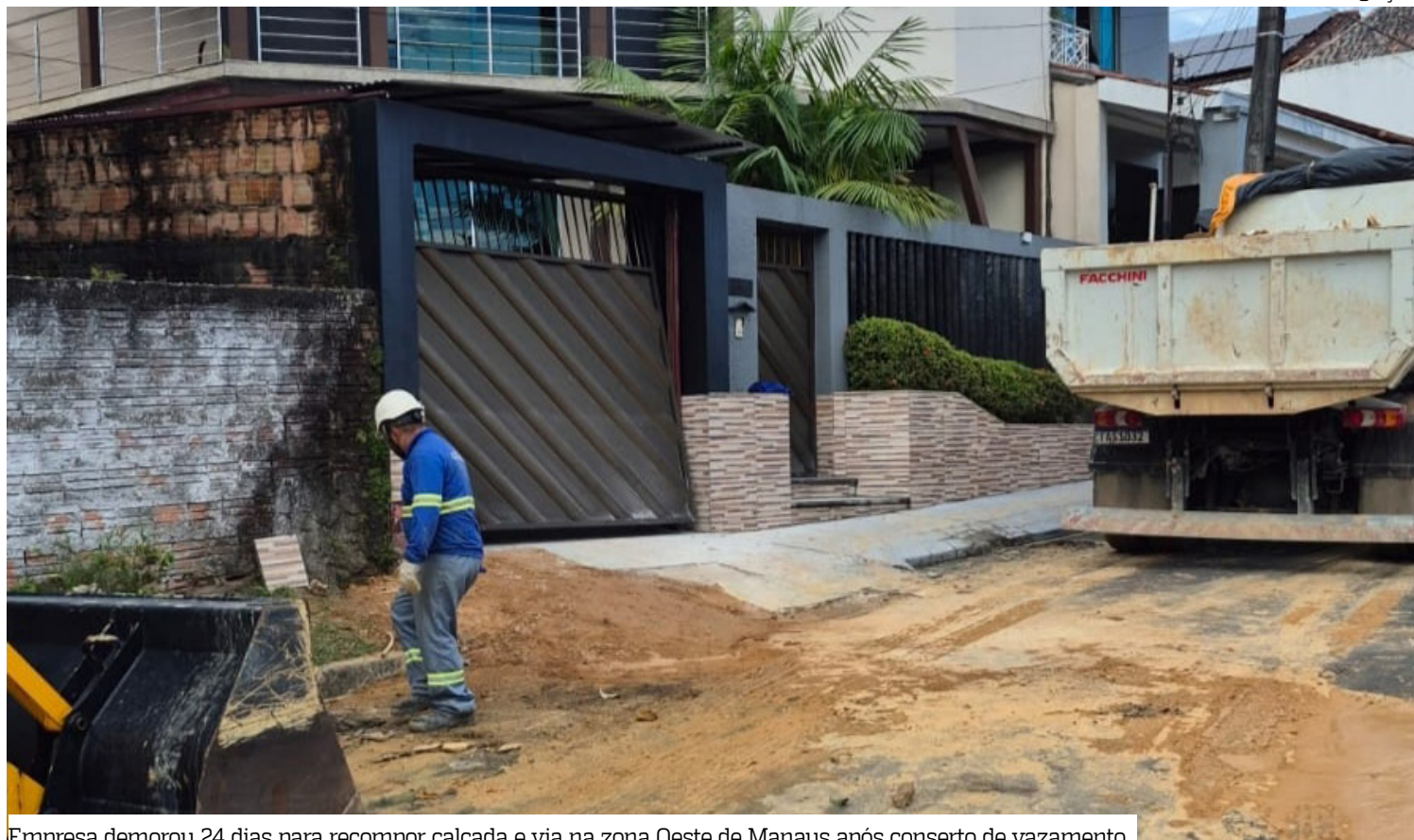
Empresa demorou 24 dias para recompor calçada e via na zona Oeste de Manaus após conserto de vazamento
