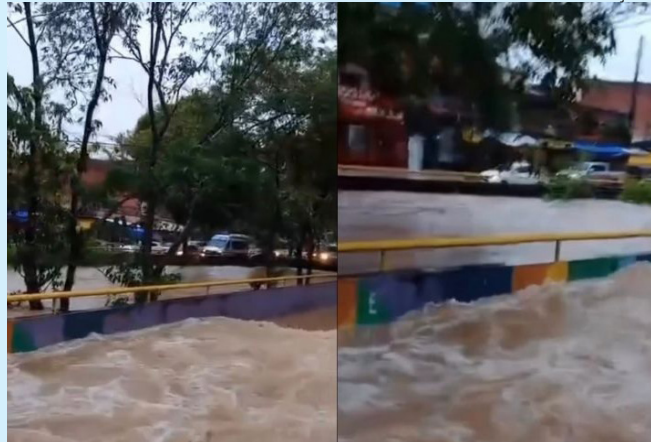
Avenida Brasil ficou totalmente alagada durante temporal
