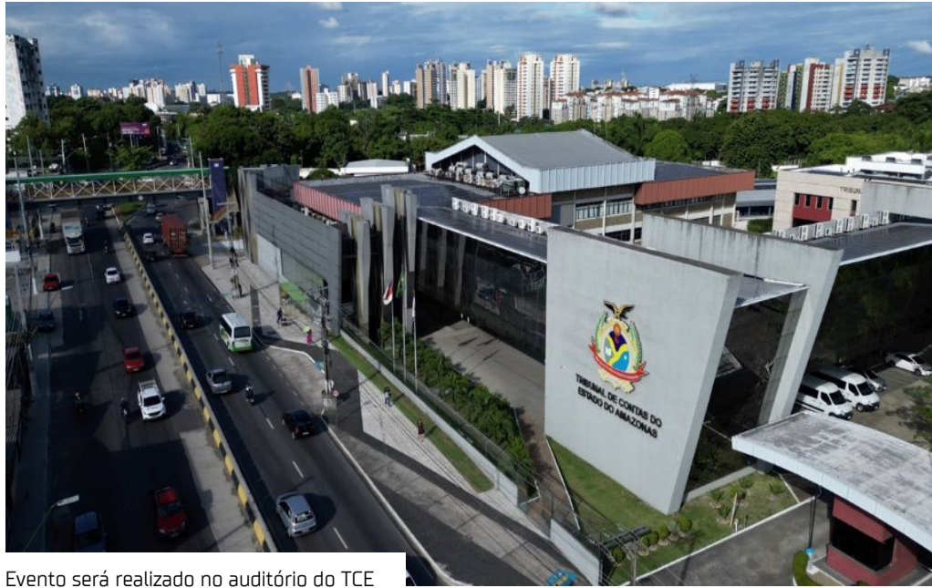
Evento será realizado no auditório do TCE
