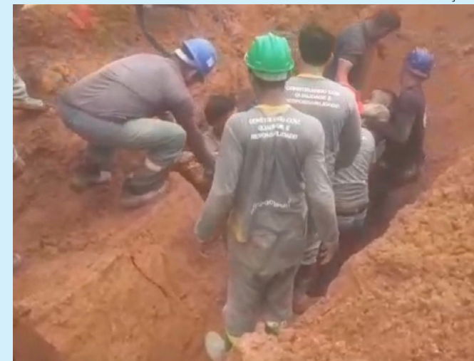
Fiscalização do Implurb interditou obra após acidente fatal
