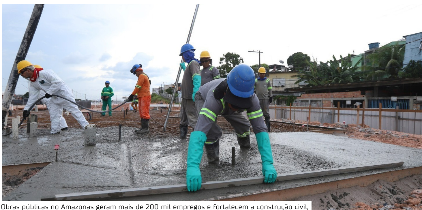
Obras públicas no Amazonas geram mais de 200 mil empregos e fortalecem a construção civil.
