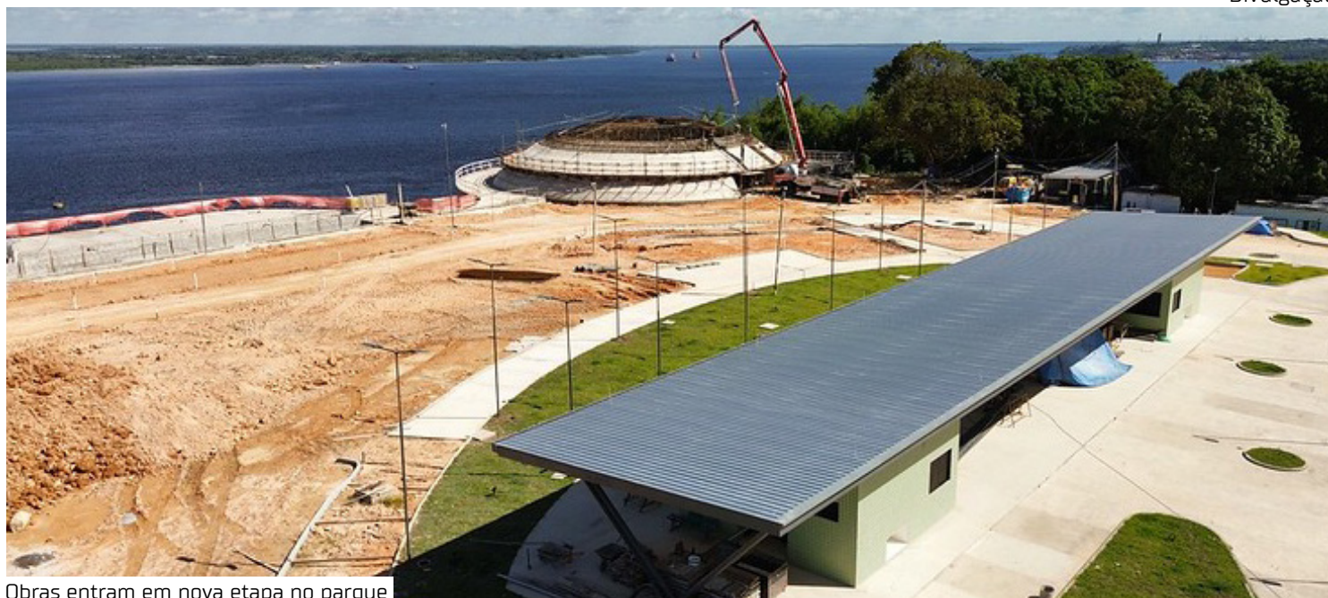
Obras entram em nova etapa no parque
