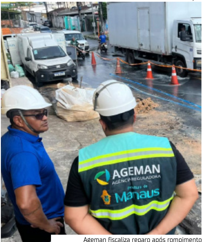
Ageman fiscaliza reparo após rompimento
