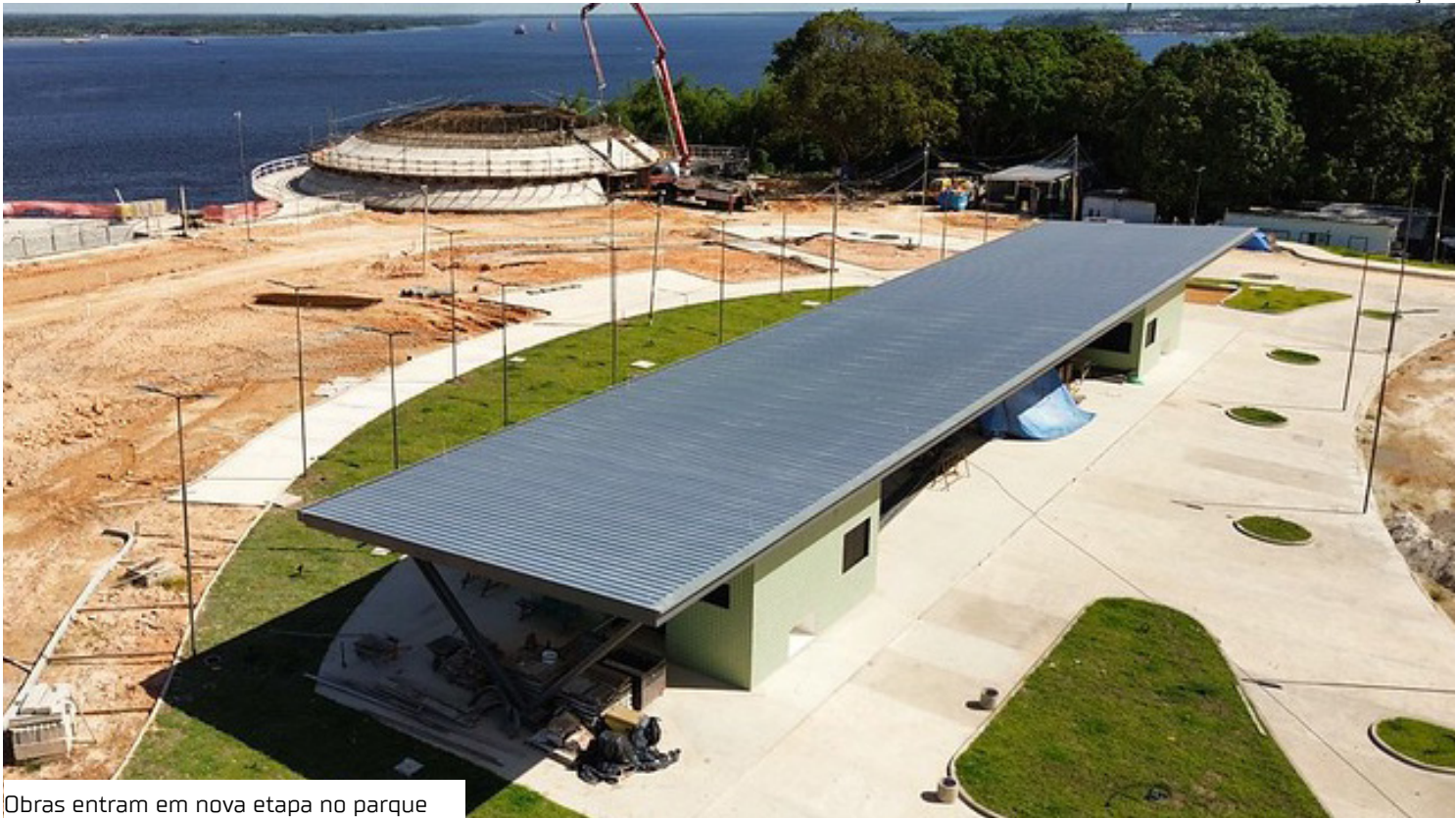
Obras entram em nova etapa no parque
