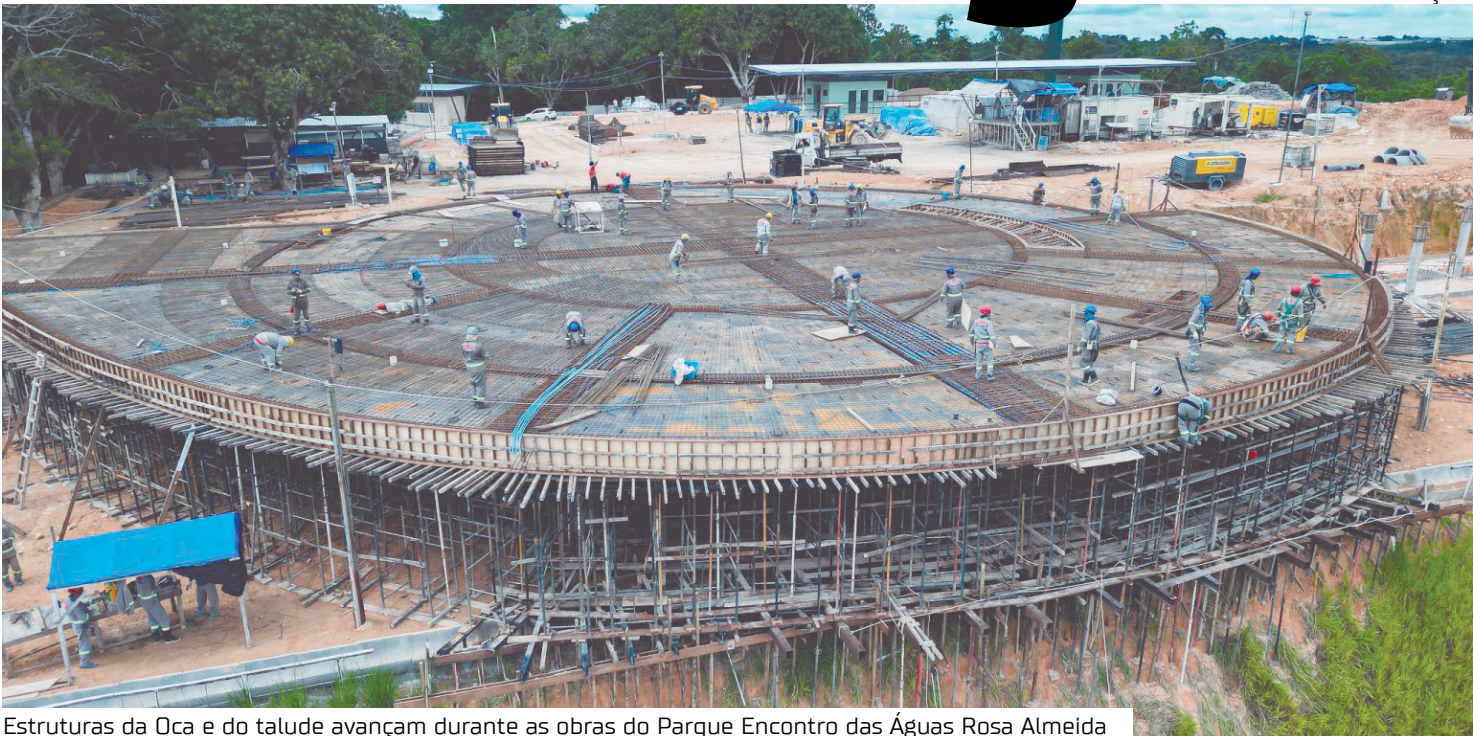
Estruturas da Oca e do talude avançam durante as obras do Parque Encontro das Águas Rosa Almeida
