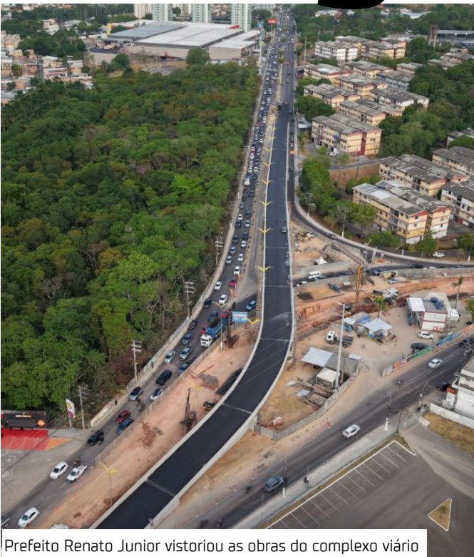
Prefeito Renato Junior visitou as obras do complexo viário
