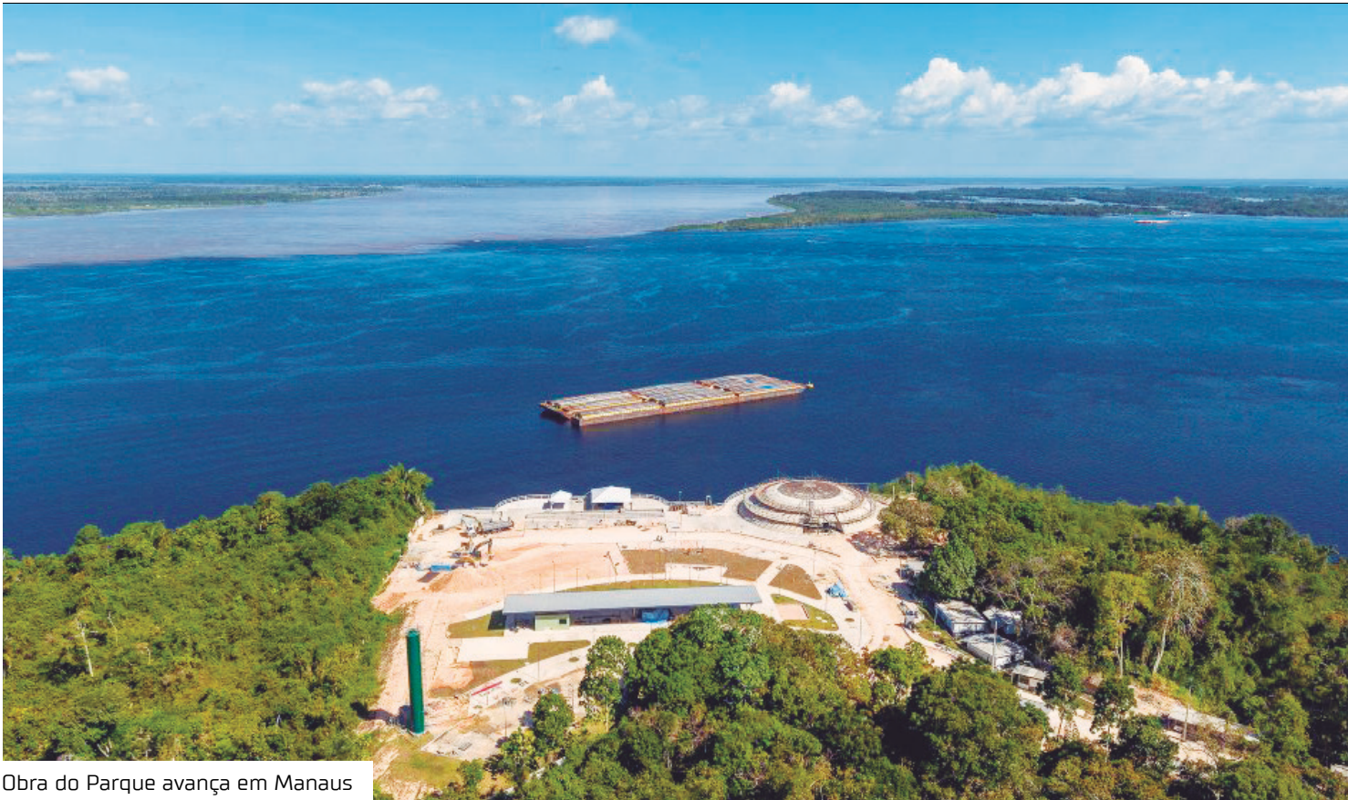
Obra do Parque avança em Manaus
