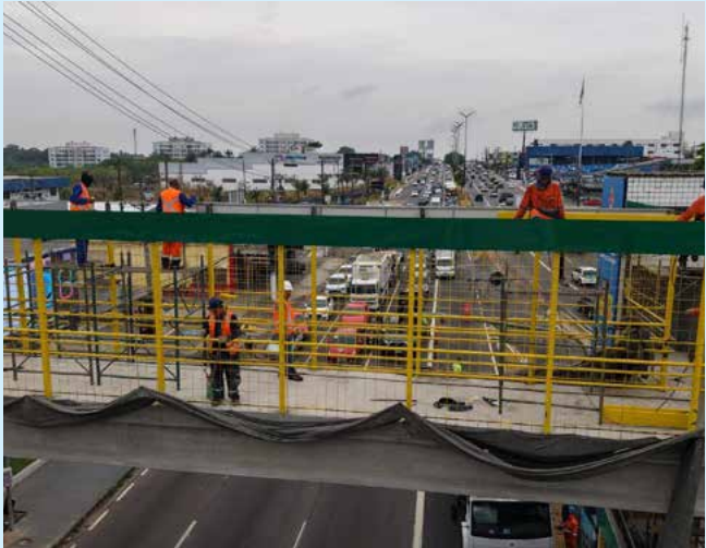
Estrutura foi reconstruída após acidente ocorrido em julho
